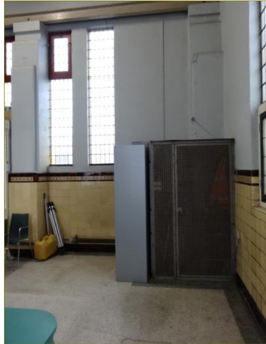
Voormalige schakelkast zuidzijde
