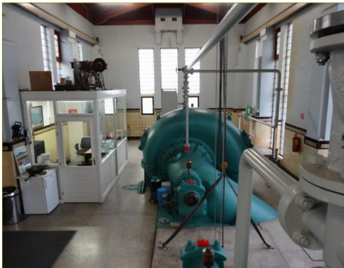
Machiniekamer gezien richting zuiden
