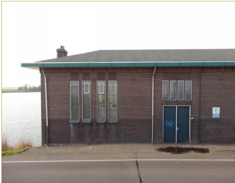
Voorzijde gemaal De Poel (Oostgevel)
