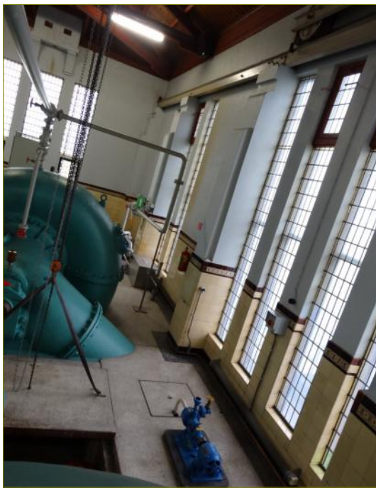
Machiniekamer - binnenzijde westgevel
