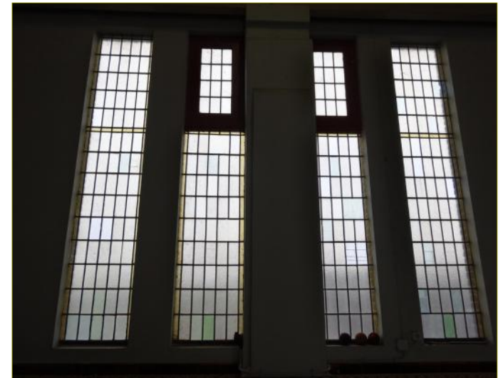
Glas-in-loodbeglazing met houten valramen
