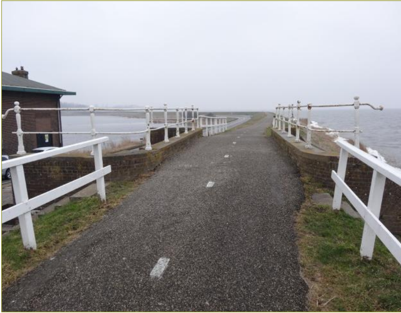
Fietspad over duikersluis en dijklichaam
