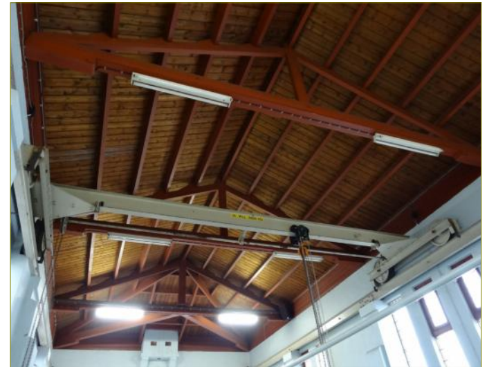
Kapconstructie en kraanbaan gezien richting zuiden
