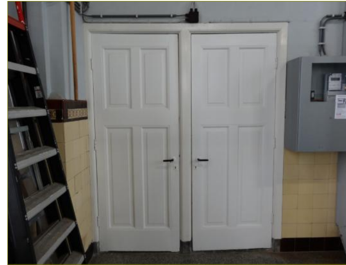
Toegangen dienstruimte en toilet met wasruimte
