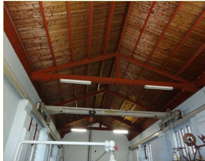
Kapconstructie en kraanbaan gezien richting noorden
