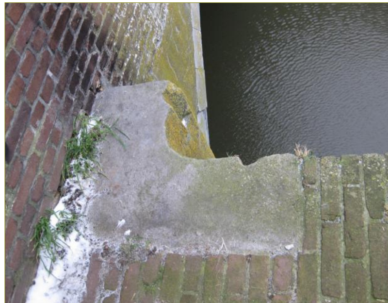
Taatspunt voormalige sluisdeuren
