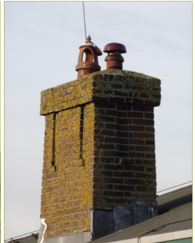
Schoorsteen met keramische schoorsteenpotten
