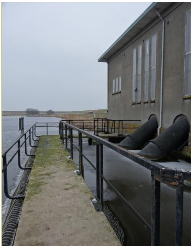
Loopvlonder waterzijde (westgevel)
