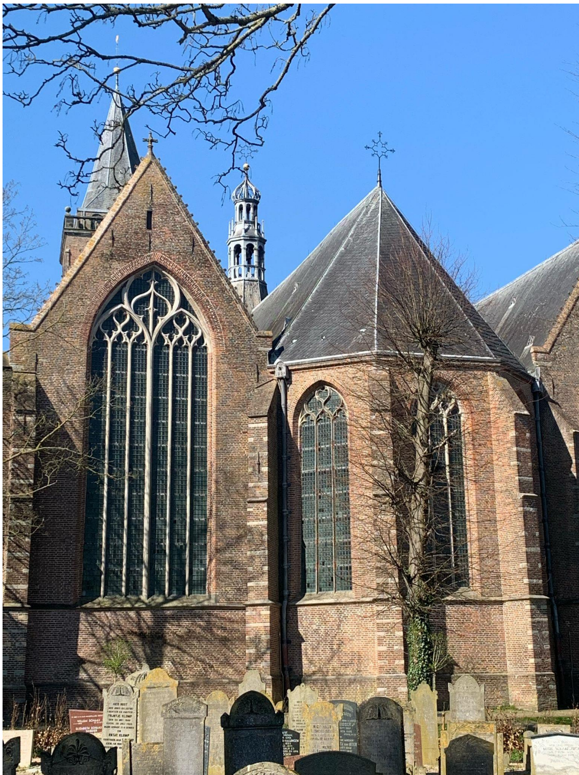
Nr.9 Zicht op de kerk vanaf begraafplaats met zicht op de dakvlakken waar zonnepanelen geplaatst worden. Gemeente Waterland.
