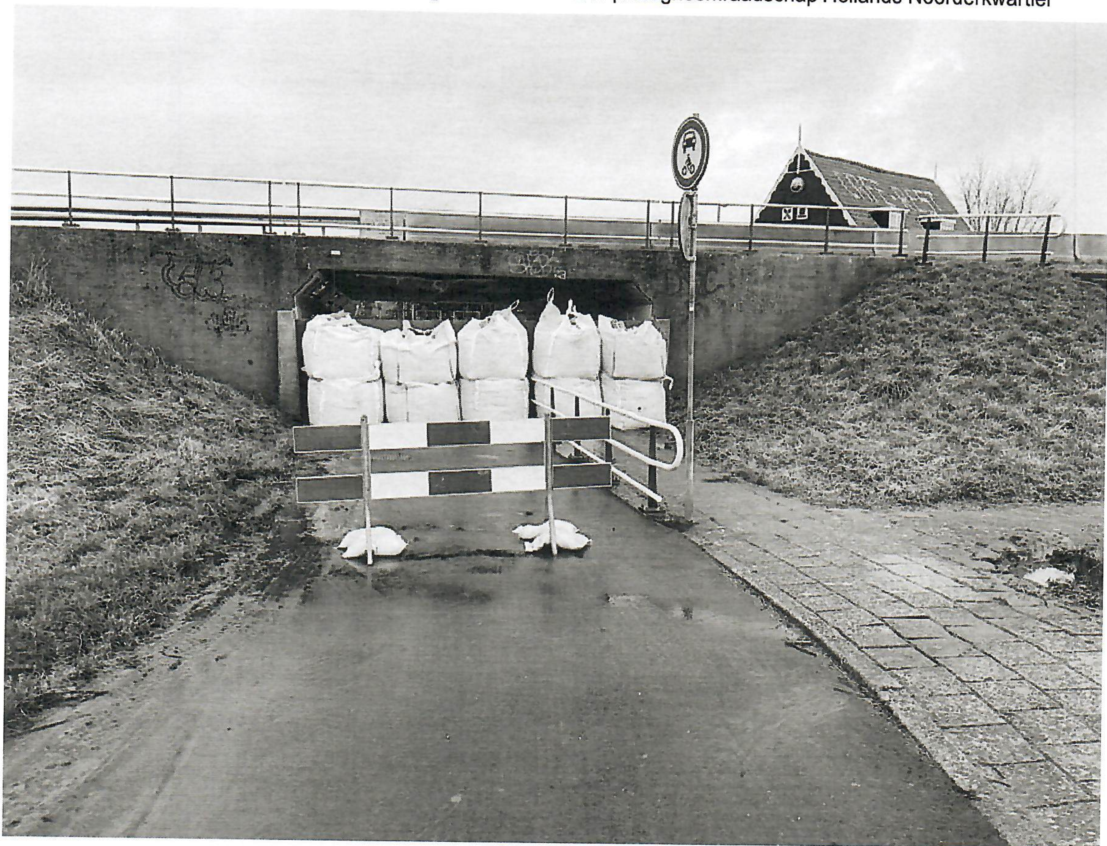
De fietstunnel bij de Broekerhaven in Bovenkarspel is preventief dichtgezet met schotbalken en big bags.
