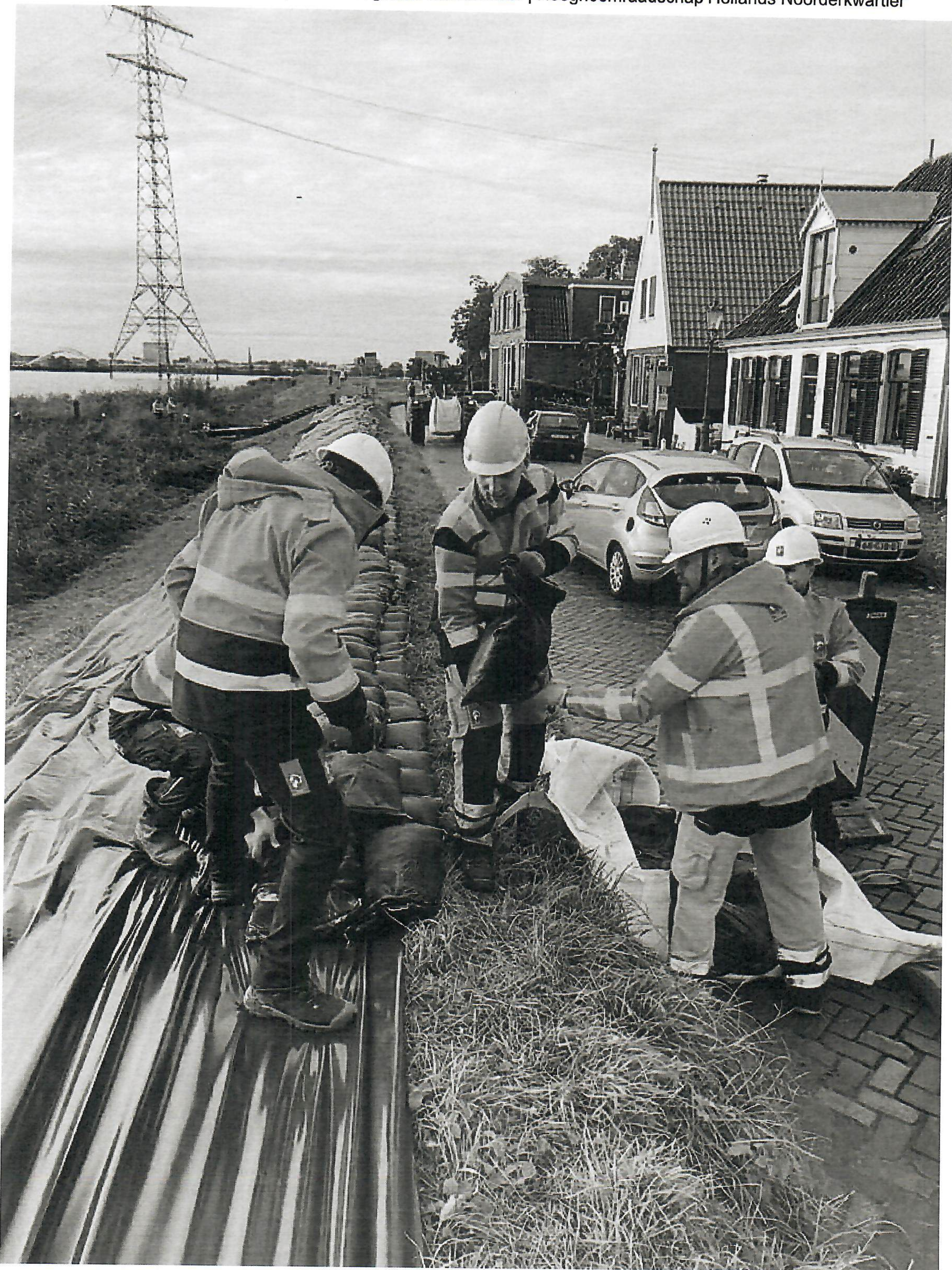
Op 19 oktober 2023 is in Durgerdam reeds geoefend met het aanbrengen van zandzakken en zeil.
