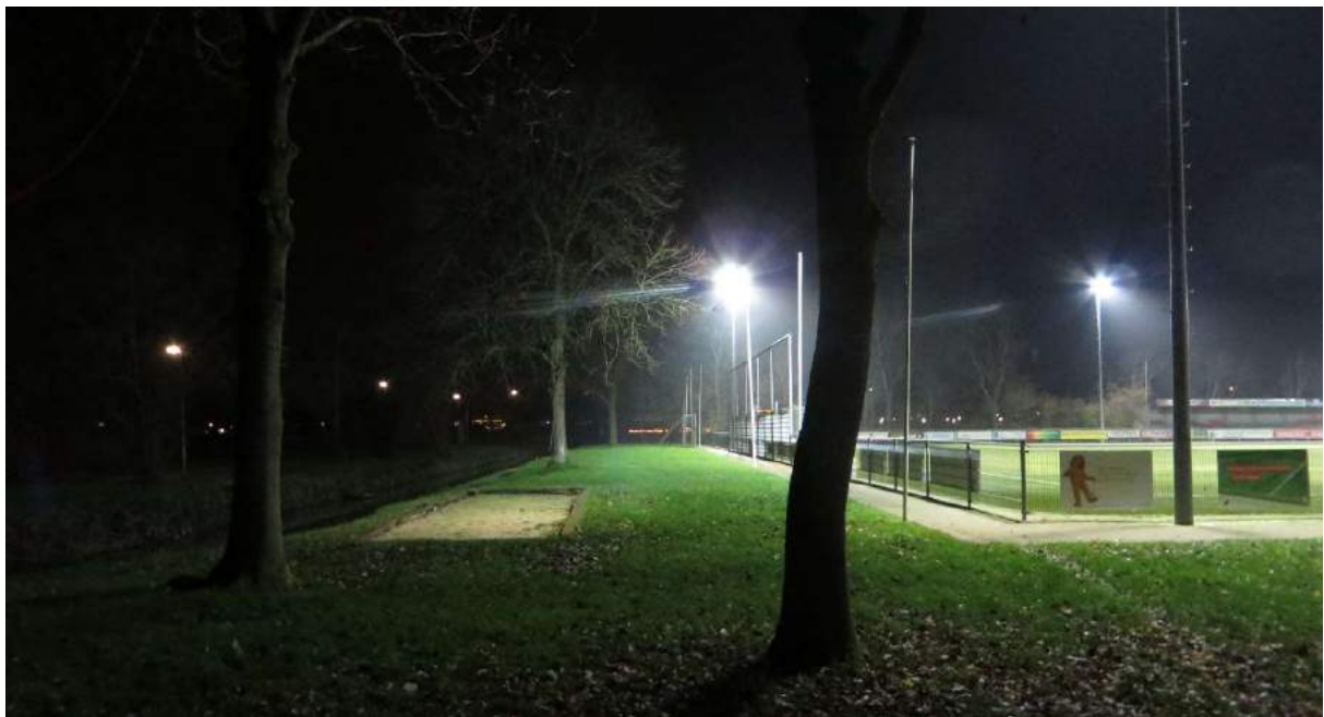
Figuur 4.4: Het hoofdveld gezien vanaf de zijkant. Aan de andere zijde van de sloot (links op de foto) worden de nieuwe woningen beoogd. De verlichting staat redelijk goed afgesteld en verlicht voornamelijk het veld en slechts in beperkte mate de omgeving.
