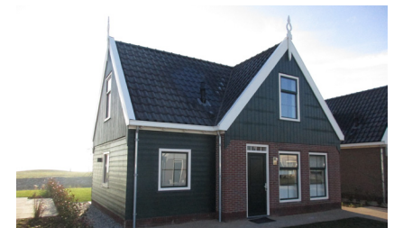
Alternatief materiaal voor hout: Werzalith (onderhoudsvrij)
