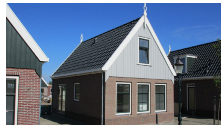
Alternatief materiaal voor hout: Werzalith (onderhoudsvrij)
