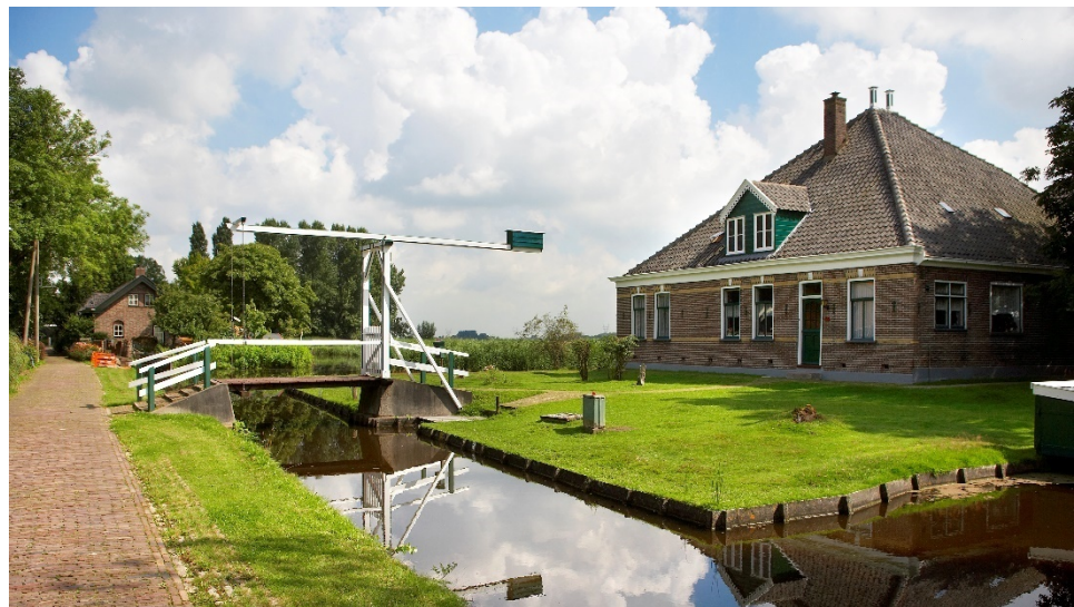
Foto: Stolpboerderij in Watergang met karakteristieke ophaalbrug Illustratie onder: standaardtype Noord-Hollandse stolp
