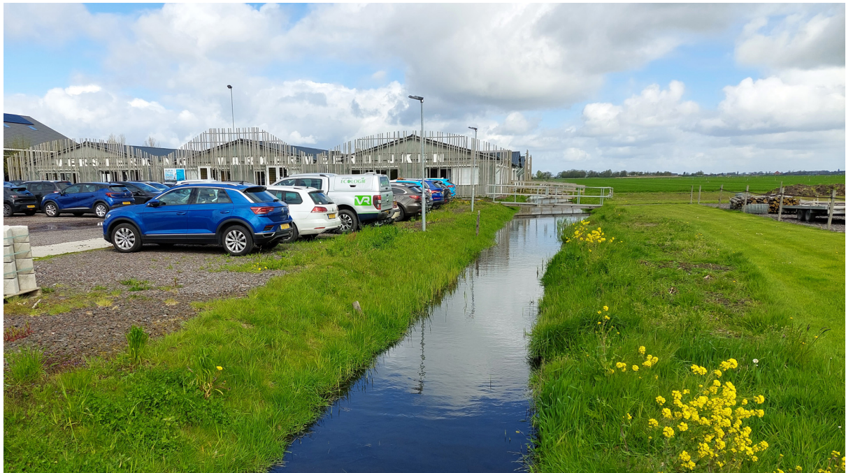
figuur 2.3 - Huidige situatie perceel Hoogedijk 1D, met het tijdelijke projectkantoor Alliantie Markermeerdijken op de achtergrond, parkeren op de voorgrond en de bestaande sloot met grastalud direct oostelijk daarvan
