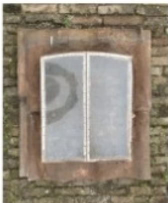
Dakvenster. (authentiek) Enkelglas. Isolatie wordt aan de binnen kant opgelost.
